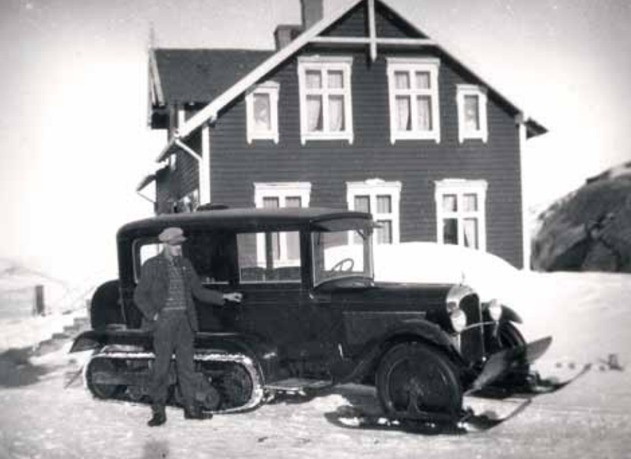
Til venstre: F-12428 hadde et overbygd rom bak kupéen. De kjørte med både ski og hjul, ikke bare på ski, siden de delvis kjørte på veiene. Bilde av Kari Hovland.
