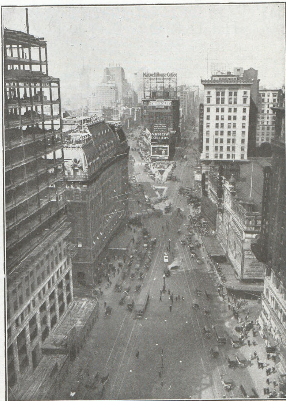
FIG. III.—Vista de la célebre New-York Times Square. A la izquierda y en primer término se encuentra el edificio en construcción de la famosa casa "Paramount Films", y a continuación, el aristocrático "Hotel Astor". Obsérvense los numerosos anuncios luminosos
