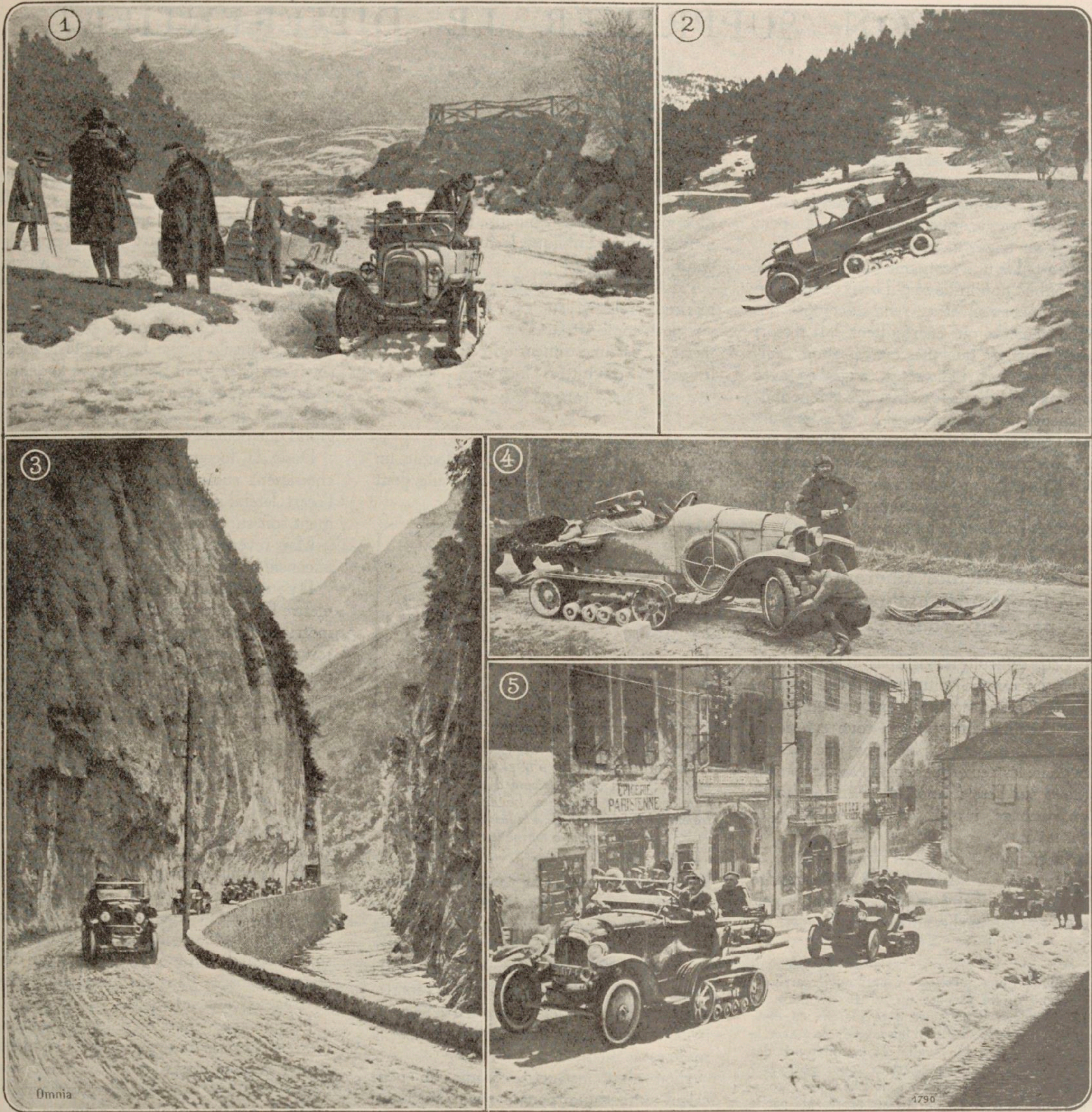
DANS LES PYRÉNÉES : LES VOITURES A CHENILLES DANS LA NEIGE ET DANS LA BOUE. = 1. Les Citroën-Kégresse à Font-Romeu. = 2. Une descente à pied vers Odeillo. = 3. Dans le défilé de Saint-Georges (gorges de l'Aude). = 4. La neige a fait place à la boue : les skis des roues avant sont retirés. = 5. La traversée du village de Mont-Louis.
