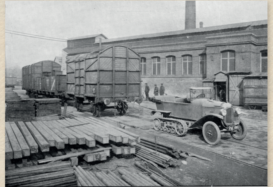
Manœuvre intérieure de wagons d'approvisionnement remorqués par un tracteur Citroën-Kégresse.
