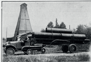
Au milieu : Transport de poteaux en ciment armé
