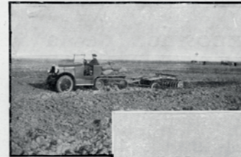
L'Autochenille dont la plateforme a été chargée de sacs de sables pour augmenter l'adhérence traîne un pulvérisateur.
