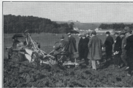
L'Autochenille Citroën labourant avec un trisoc à 25 centimètres de profondeur
