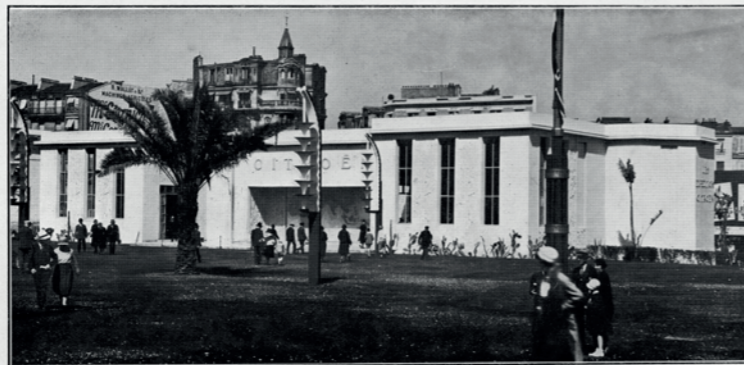
Le Pavillon Citroën qui, comme nous l'avons déjà indiqué, a été inauguré officiellement le 4 mai 1931 par le Maréchal Lyautey.
