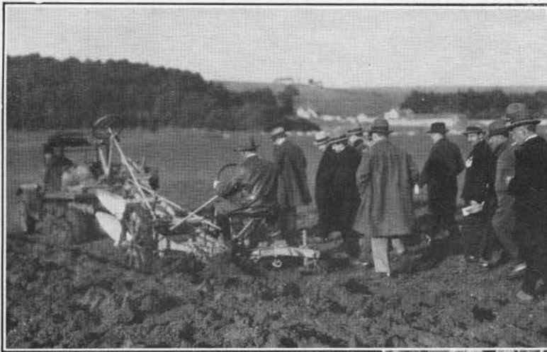
L'Autochenille Citroën labourant avec un trisoc à 25 centimètres de profondeur
