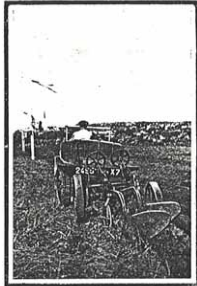
Arbeiten mit dem Zweischarenpflug mit 25 cm Tiefgang
